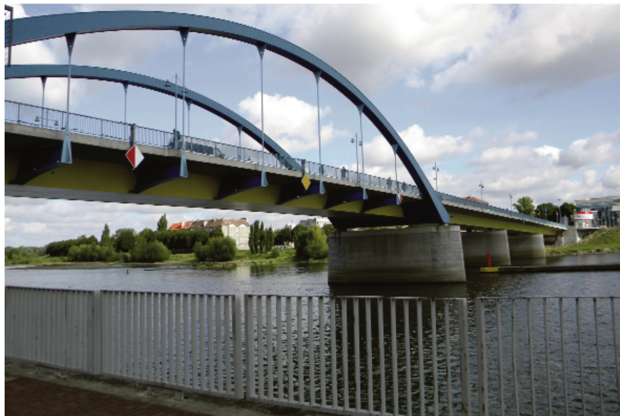
Materielle Verbindung zwischen Deutschen und Polen: Die Brücke zwischen Frankfurt an der Oder und Slubice/Dammvorstadt.
